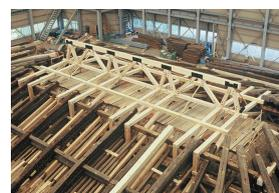
20. 補強材(方杖,垂直のトラス)
