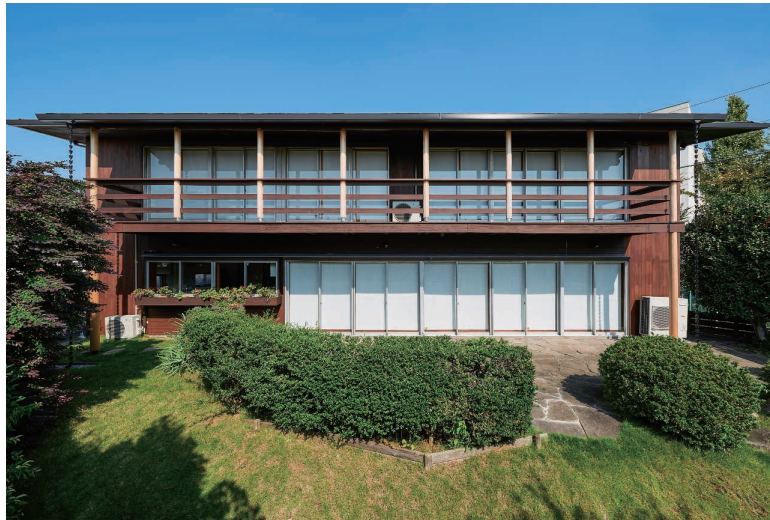
南側外観。家は高台に建ち、眺望がよい。バルコニーの手すりは幅広につくられていて、飲み物を置いて景色を眺めたいくなる。2017年撮影。
